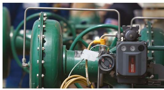
"Armaturen, die mit einem digitalen Stellungsregler betrieben werden und mit einem anlagenweiten Netzwerk verbunden sind, können große Mengen an Zustands- und Leistungsdaten generieren."
